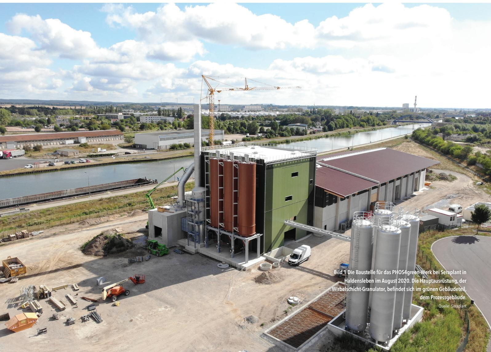
Bild 1 Die Baustelle für das PHOS4green-Werk bei Seraplant in Haldensleben im August 2020. Die Hauptausrüstung, der Wirbelschicht-Granulator, befindet sich im grünen Gebäudeteil, dem Prozessgebäude.
